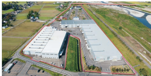
● サンエツ金属プレジジョン工場・インキュベーション工房 精密部品を生産。(黄銅製カメラマウントの世界シェアは80%) 1,600トンフリクション鍛造機を保有。
