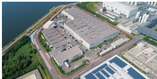
● 日本伸銅本社・堺工場 | 敷地面積：38,054㎡ 世界最新鋭の設備により黄銅棒を生産。(サンエツ金属と合わせた黄銅棒のシェアは55%) 圧力制御式铸造炉、電磁攪拌システム搭載横型連続铸造ライン、3,000トン間接押出機を保有。
