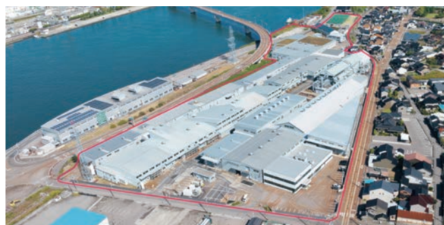
● サンエツ金属高岡事業所(線工場・めっき工場) | 敷地面積：58,300㎡ 黄銅線を生産。(黄銅線の生産量は日本一) 2,500トン直接押出機と面圧が世界最強の2,150トン間接押出機を保有。
