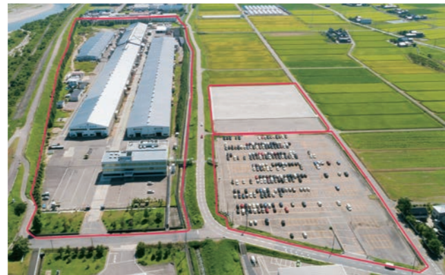
● サンエツ金属本社・砺波工場 | 敷地面積: 333,492㎡*
