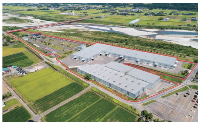
● サンエツ金属プレジジョン工場・インキュベーション工房
