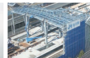
北陸新幹線金沢駅舎
